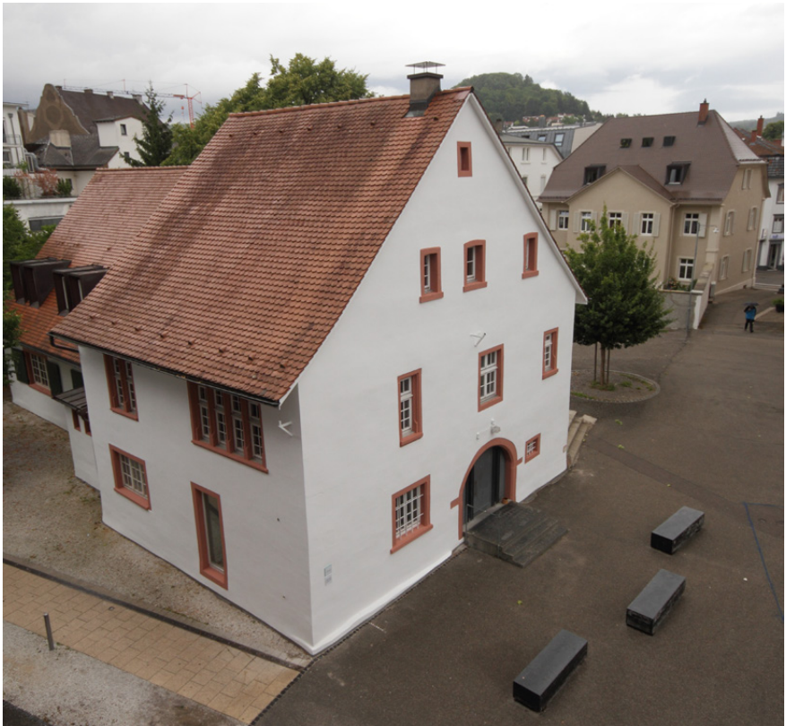
Gemeindehaus „Alte Feuerwache“
